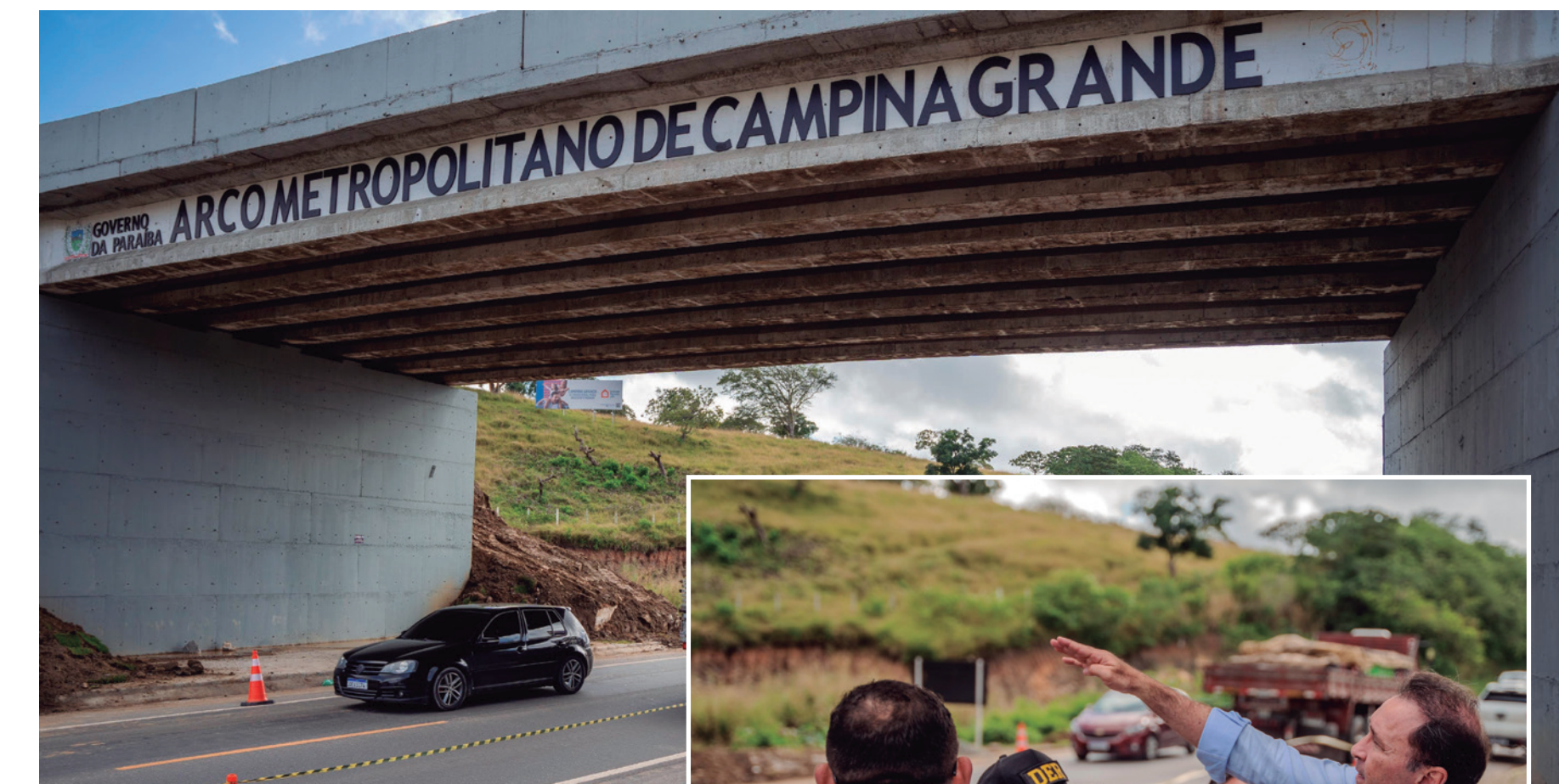
Segundo o secretário, a obra no viaduto de CG está perfeita
